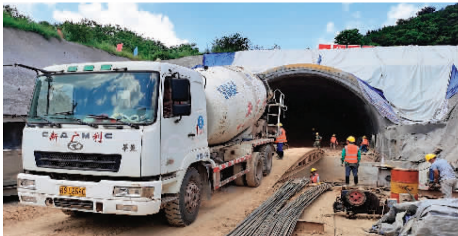
灌阳至平乐高速牛仔尾隧道正在施工。 记者沈青 摄
