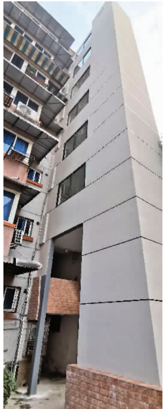
石油六公司小区C区13栋已经投入使用的电梯。
