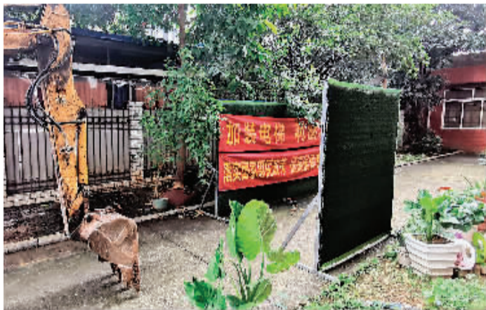
地矿院小区的施工现场。
