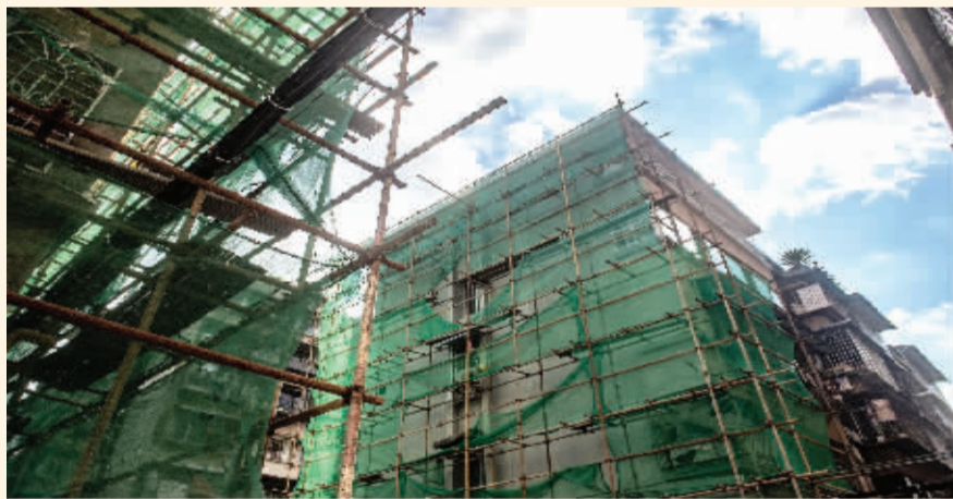
在丽中路,一些老旧小区的外墙正在进行改造。
