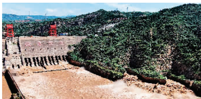
这是7月15日拍摄的进入汛期防洪运用的三门峡水利枢纽(无人机照片)。新华社发
