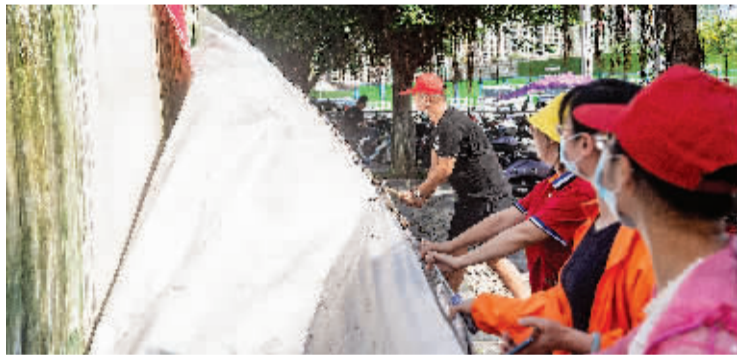
志愿者在骏鸾路拆除已经陈旧的墙面广告。 记者滕嘉 摄
