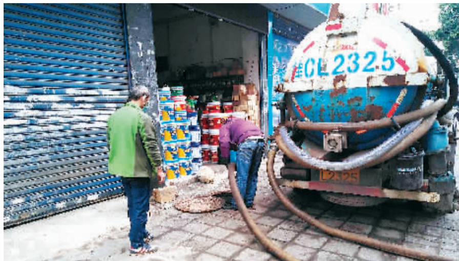
20日，相关工作人员到现场疏通管道。 记者周子琪 摄
