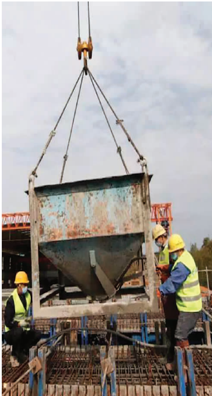
3月10日，荔浦至玉林高速公路施工现场。(荔玉高速建设指挥部供图)
