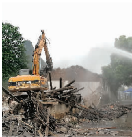
拆除现场。 记者谭熙 摄
