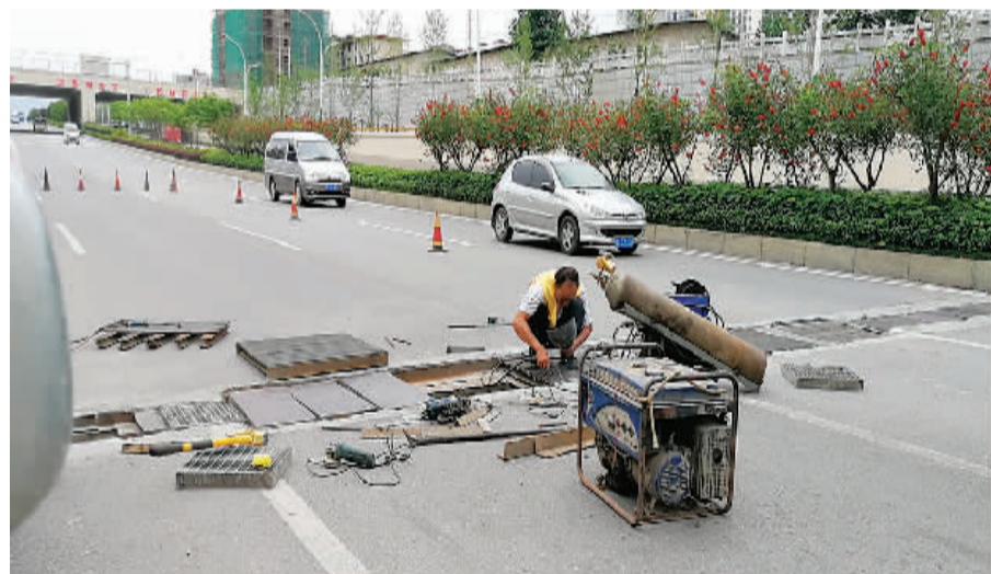
施工人员正在对维修后的雨水算进行加固。 记者陈晓东 摄
