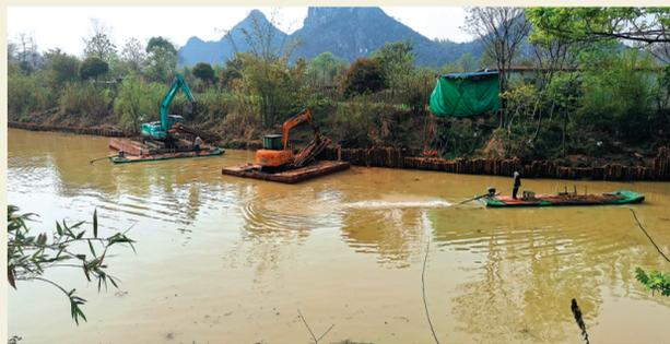
▲大型浮吊式长臂挖掘机在桃花江(灵川段)两岸生态修复工程项目中施工。
