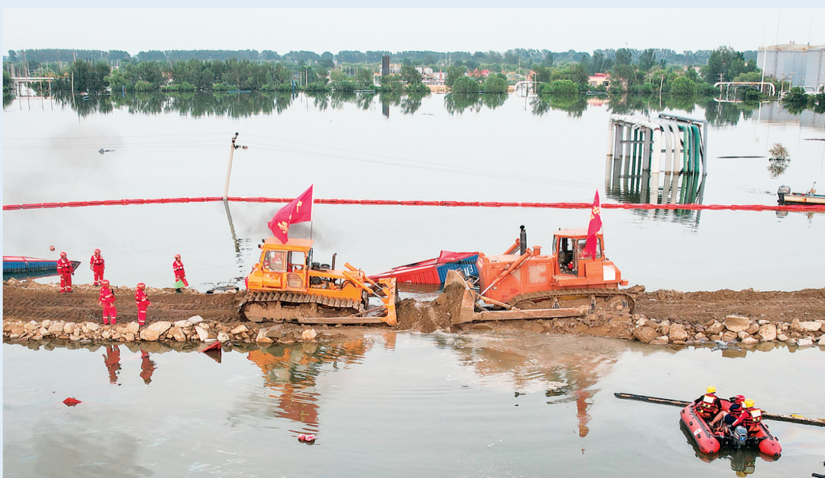
▲8月6日，抢险人员在溃口处完成合龙作业（无人机照片）。新华社发（中国安能集团提供）
