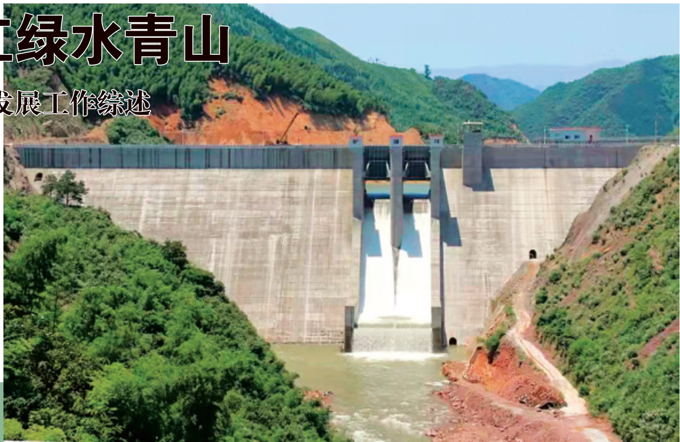
桂林市防洪及漓江补水工程
