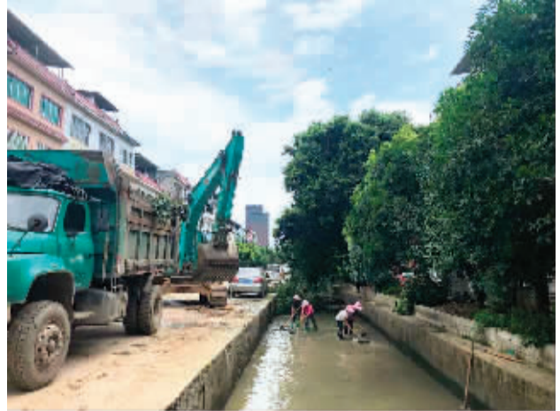
▲临桂区组织创城人员清理渠道
