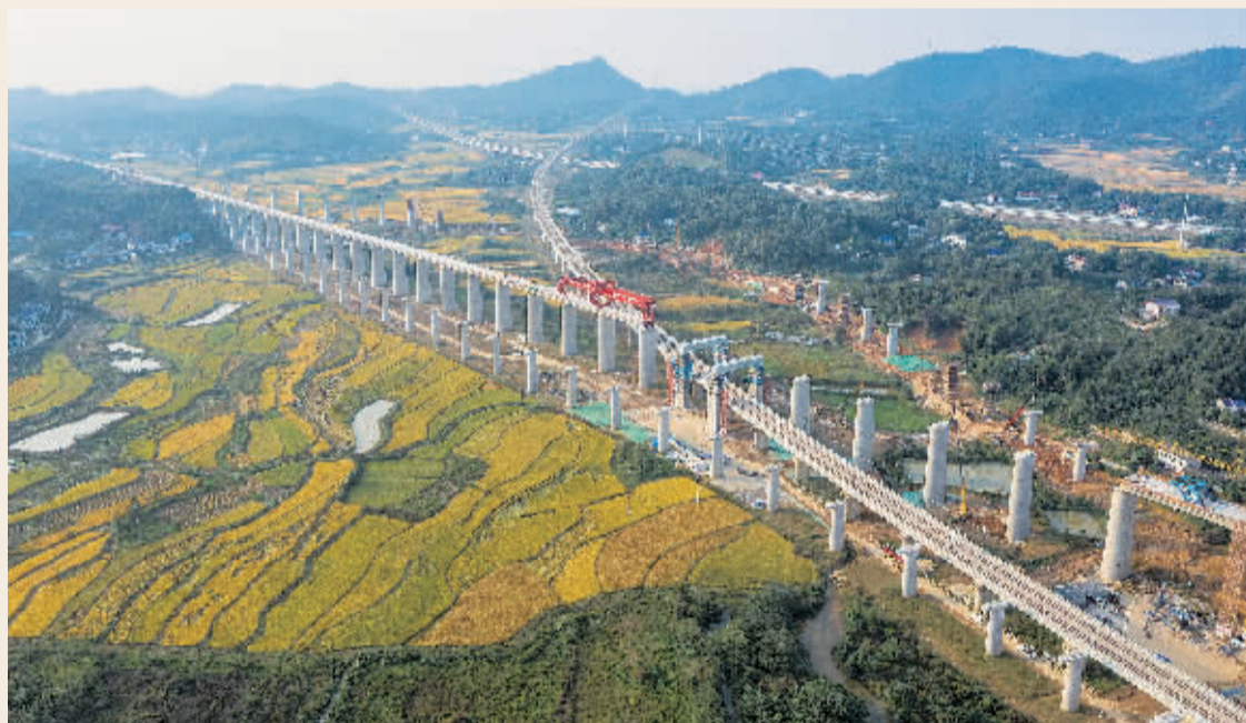
▲这是10月10日拍摄的常益长铁路黄桥大道特大桥桥梁架梁施工现场（无人机照片）。目前，常（德）益（阳）长（沙）铁路益长段进入架梁高峰。常益长铁路正线全长约157公里，设计时速为350公里，是国家“八纵八横”高速铁路网的重要组成部分，其中益长段正线全长约65公里。新华社记者杜华举摄
