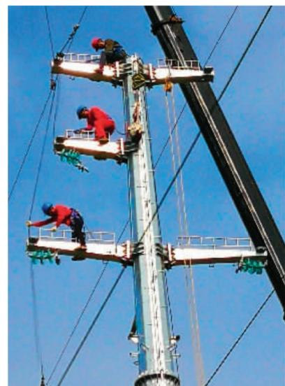
日前，电力工人在灵川县灵川镇的35KV灵城线铁塔上对电缆、光缆进行下地布线施工。灵川供电局抓紧组织安装电缆、光缆线路，以确保周边项目建设顺利推进和居民用电的安全稳定。记者刘健 通讯员廖梓杰 摄
