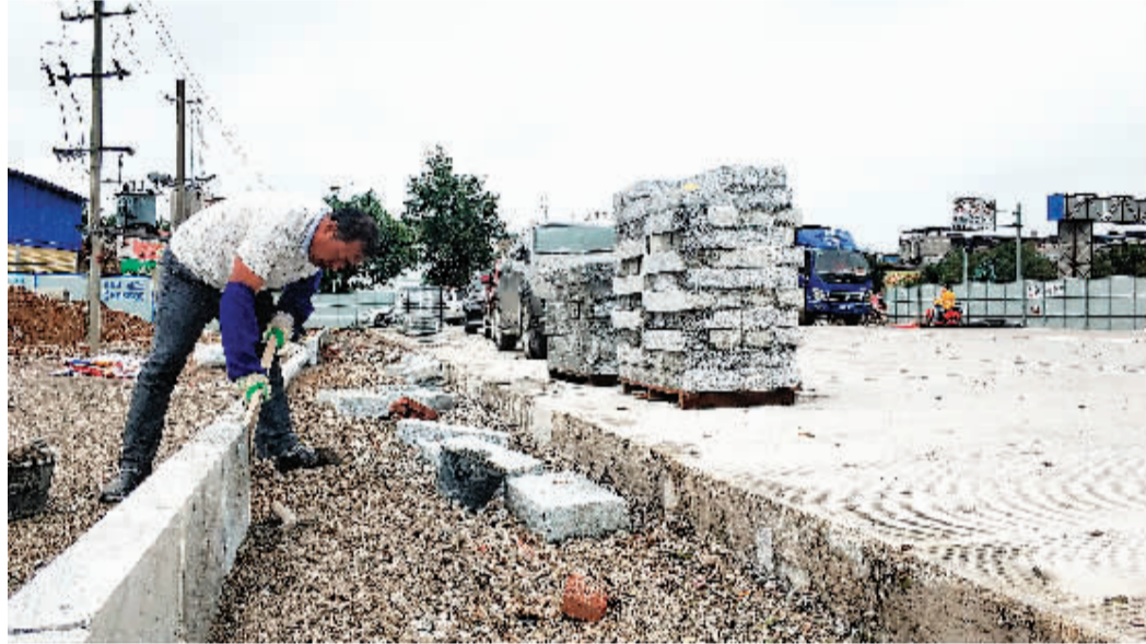
▲施工人员在非机动车道和人行道进行施工。
