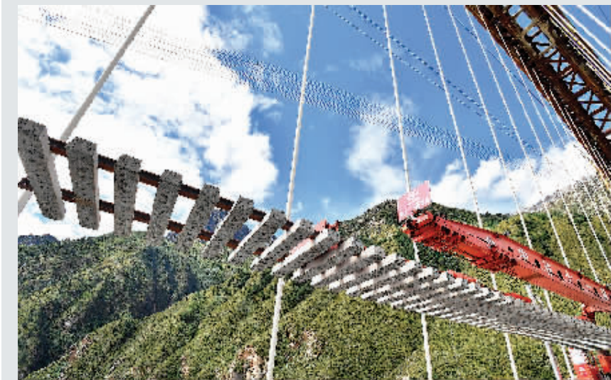
▲9月20日，中铁十一局工程技术人员在藏木特大桥上铺轨。当日，伴随着阵阵轰鸣声，铺轨机吊着一排25米长的轨排，缓缓落在藏木雅鲁藏布江特大桥上，标志着拉萨至林芝铁路第三座跨越雅鲁藏布江特大桥已经铺轨，至此正线铺轨168公里，距离2021年建成通车更近了一步。 拉萨至林芝铁路是国家“十三五”规划重点工程项目，全长435公里，设计时速160公里，是西藏首条电气化铁路，全线16次跨越雅鲁藏布江，地质条件复杂，桥隧比高达75%。 新华社记者觉果 摄
