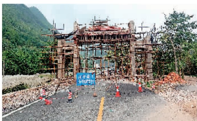
▲正在建设的门楼。(漠川乡政府供图)
