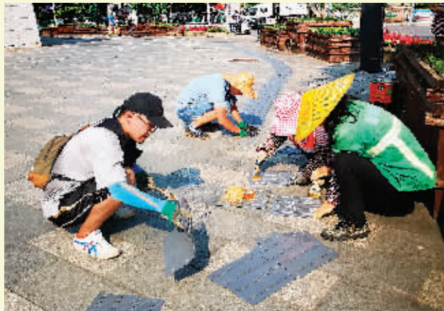
改造盲道。 通讯员李腾利 摄
