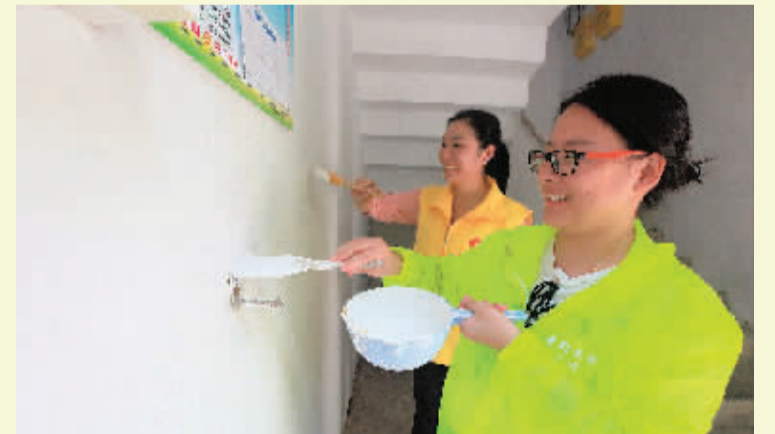
▲随着社区工作人员手中的小刷子舞动,楼道和围墙等墙面变得焕然一新。连日来,叠彩区北门街道办事处组织志愿者、社区工作人员对无物业老旧小区粉刷楼道近15万平方米。
