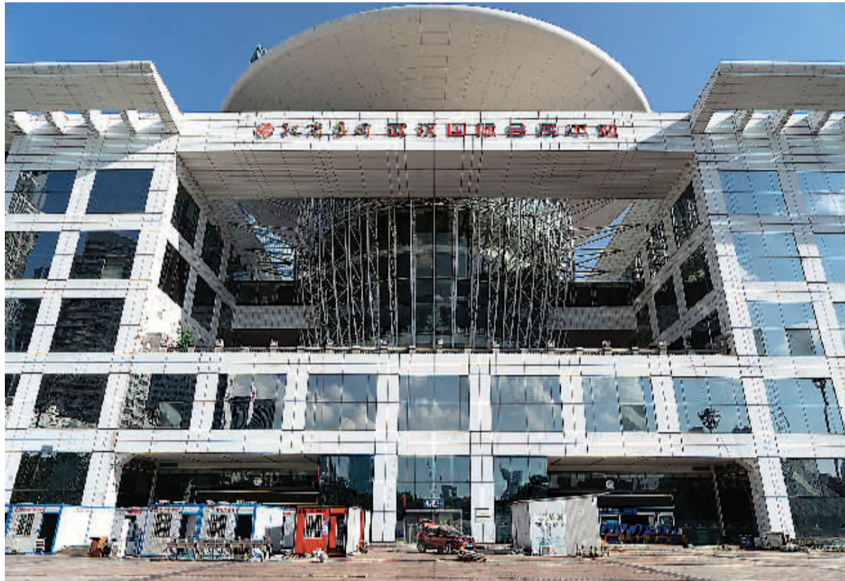
武汉江汉方舱医院正式关舱拆除
