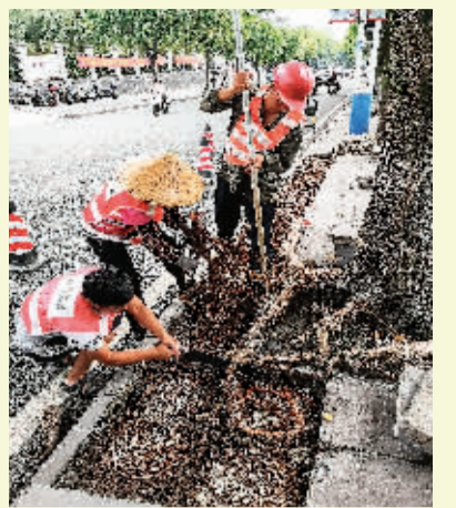
▲园林工人在处理黄葛榕路面上黄葛榕行道树的树根。通讯员李腾利 摄
