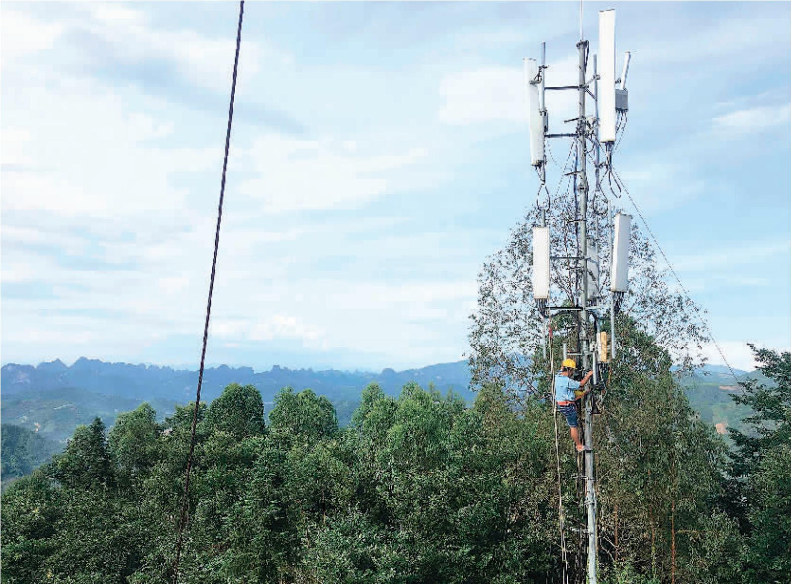
▲桂林移动技术工程师正在建设5G基站。（桂林移动供图）
