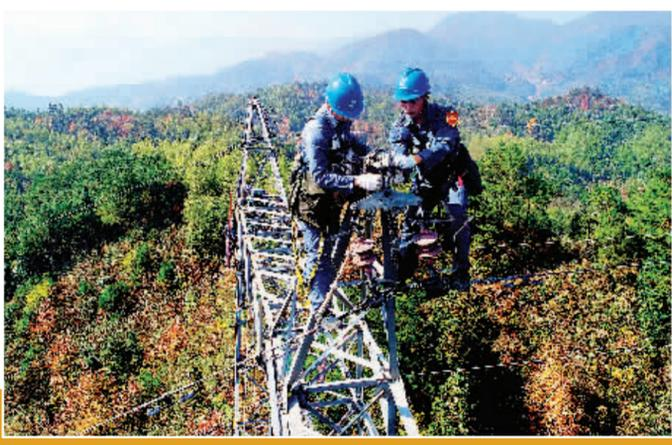
▶《抗冰保电：高空安装覆冰预警装置》 曾毅 摄
