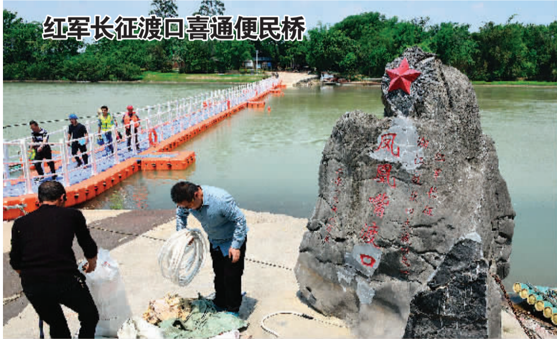
▲4月29日下午,全州县凤凰镇红军长征渡口便民桥架设完成,交付使用。全州县凤凰镇凤凰嘴渡口是湘江古渡,是红军长征湘江战役四大渡口之一。目前,凤凰嘴渡口附近正在建设新大桥。近来,此渡口的渡船出现了安全隐患,县政府及时拨款30万元在渡口架设了90米长的浮筒浮桥,在大桥建成之前供行人、非机动车过河,大大方便了和平、望高、大毕头3个村委1.1万人的生产、生活出行。
