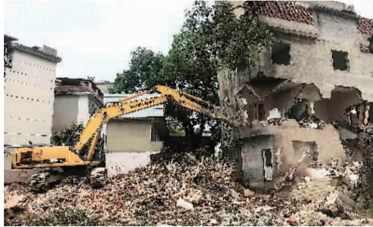
4月23日,七星区塔山片区棚户区改造项目拆迁现场。
