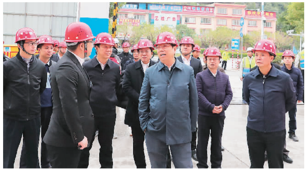
▲ 11 月 30 日,赵乐秦等市领导来到临桂万达广场项目建设工地进行调研。 记者唐侃 摄
