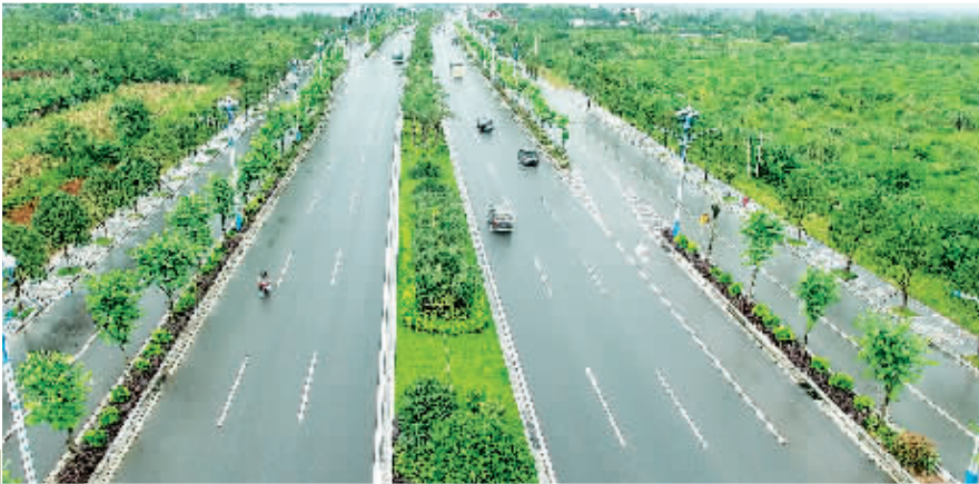
▲321国道桂林至阳朔段改扩建工程实景。
