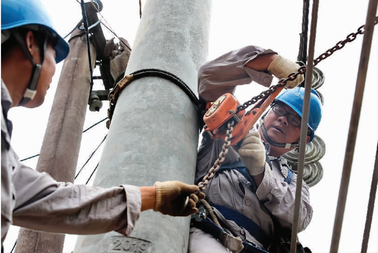
◀ 电线杆上高空紧线作业需要娴熟的业务能力和经验。
