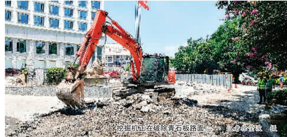
挖掘机正在破除青石板路面。 记者徐莹波 摄
